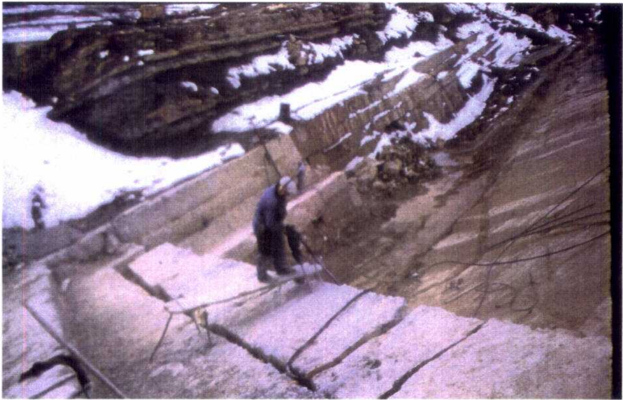
Fig. 8.- Detalle de la separación de bloques en la cantera (Est.94)
